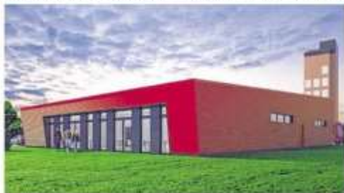
Rückansicht: Großflächige Fenster und Türen bringen viel Licht in die Aufenthalts- und Schulungsräume.
