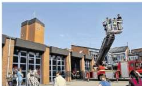
Soll in Kürze energetisch runderneuert werden: die Feuer- und Rettungswache am Florianweg. Foto: Rudolf Müller
