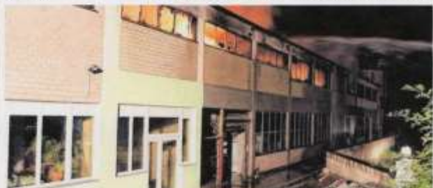
Die Lagerhalle stand komplett in Flammen. Das Feuer loderte durch das offene Dach gen Himmel. So war der Feuerschein bis in weite Entfernung zu sehen.
