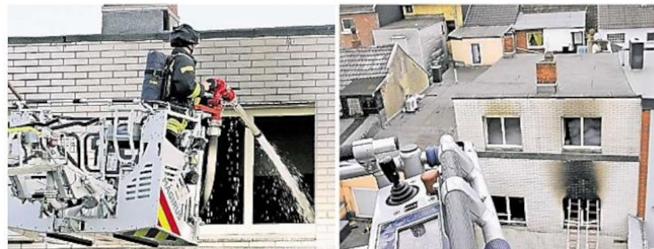
Das Feuer brach gegen 20 Uhr aus. Unter anderem kam eine Drehleiter zum Einsatz. Auch am Montagmorgen waren die Einsatzkräfte vor Ort, weil in den vielen abgehängten Decken immer wieder Glutnester aufkeimten (rechtes Bild).
